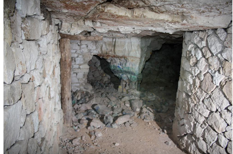
Fig. 170 : Salle J, étau en bois, pilier naturel et pilier circulaire en pierres sèches [PC]
